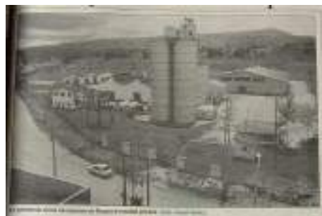
Figura 111. Estado de las instalaciones industriales antes de cambiar de uso
