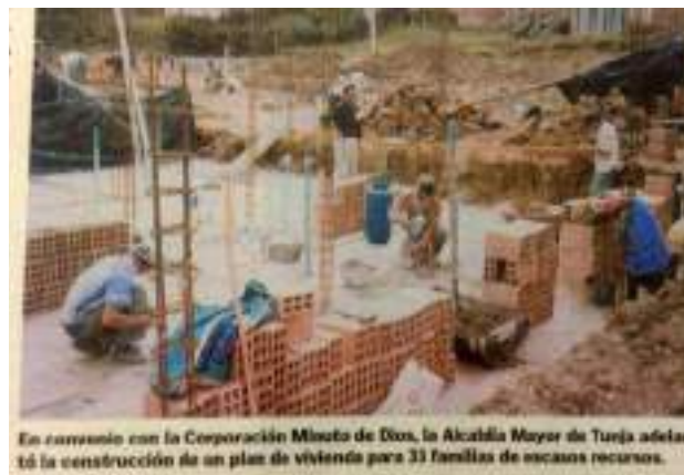
Figura 130. Construcción de casas con el Minuto de Dios
