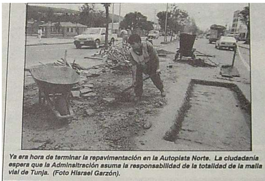
Figura 45. Repavimentación en la Avenida Norte
