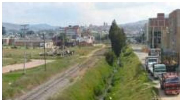
Figura 56. El río y la línea del ferrocarril
