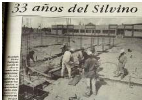
Figura 95. Construcción de la nueva sede para el "Silvino", cerca de Los Patriotas
