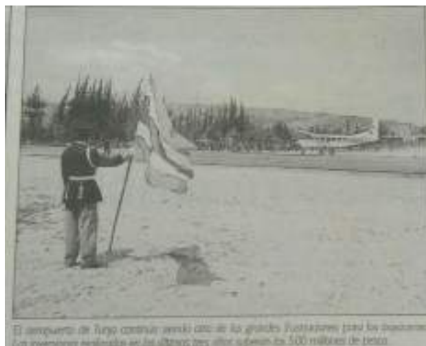
Figura 85. Aeropuerto de Tunja sin funcionar
