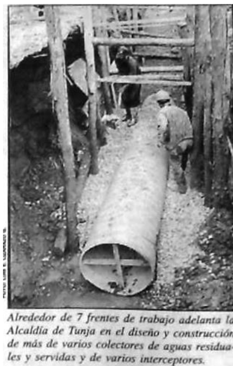
Figura 40. Modernización de redes de alcantarillado a partir de la construcción de colectores
