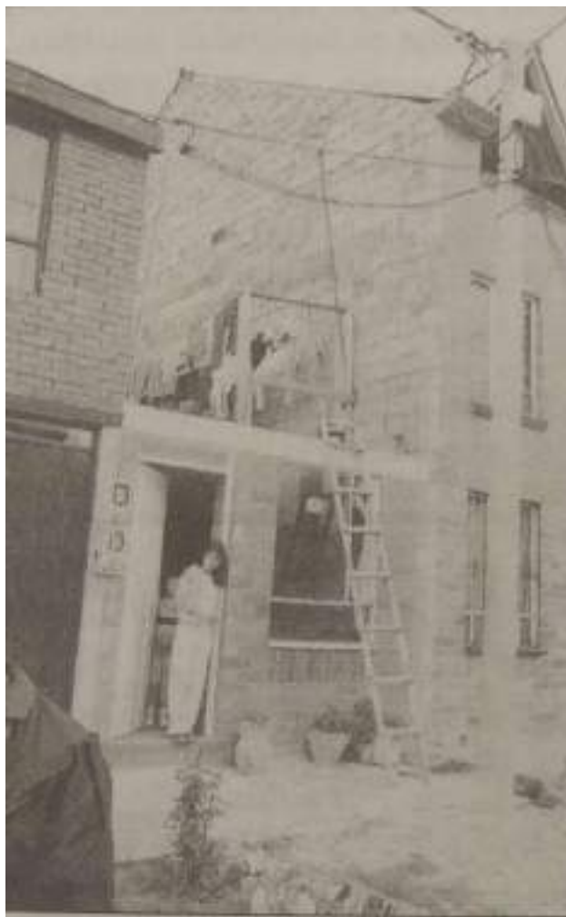
Figura 123. Comparativo entre la casa mínima entregada originalmente en Ciudad Jardín y aquella con ampliaciones
