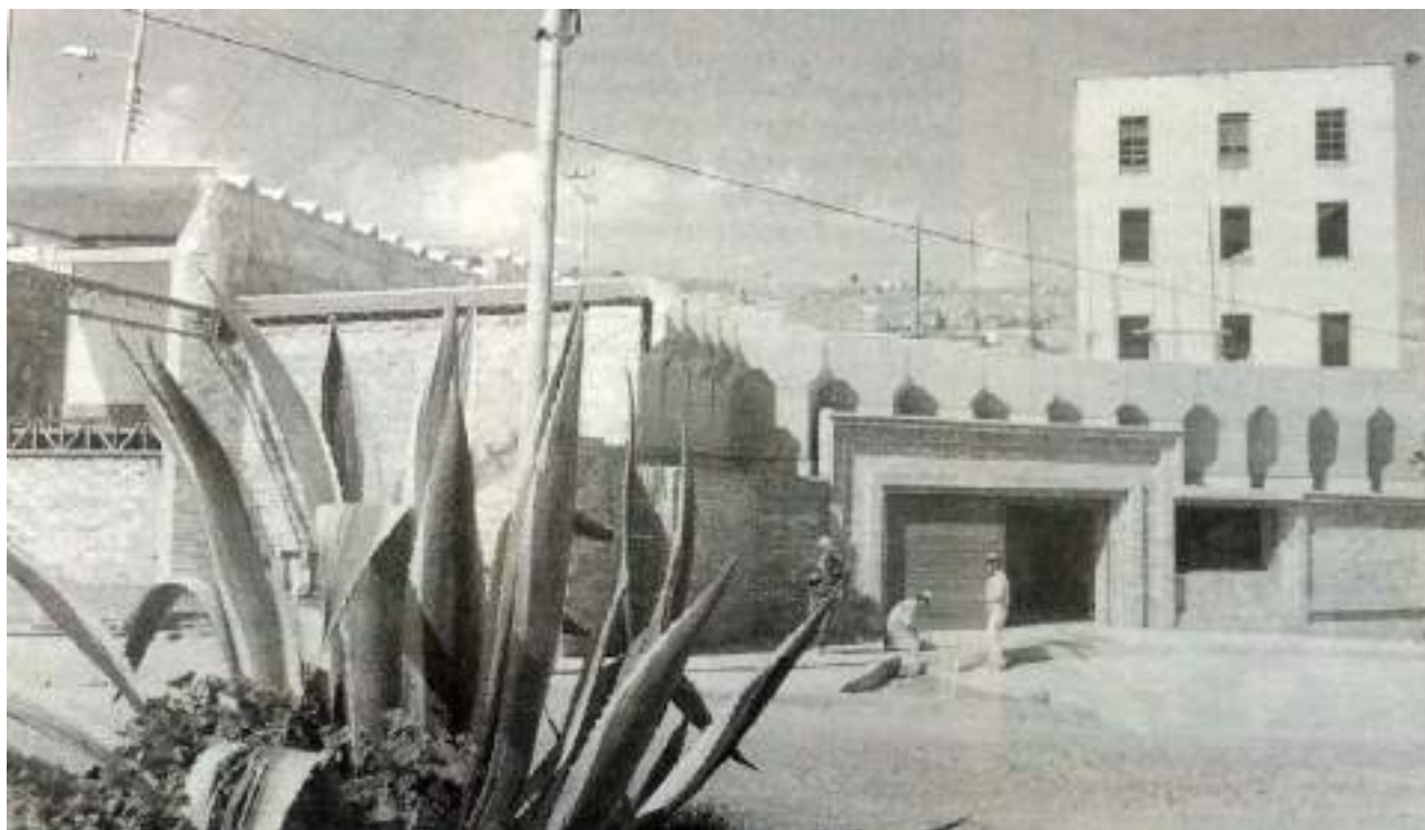
Figura 103. Nuevo centro comercial Zalema
