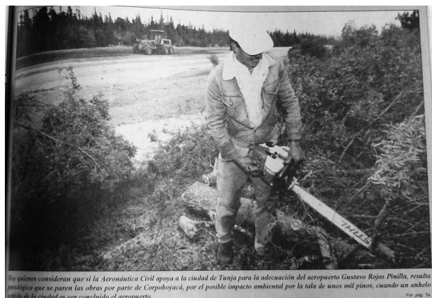
Figura 86. La pista o los pinos en el aeropuerto
