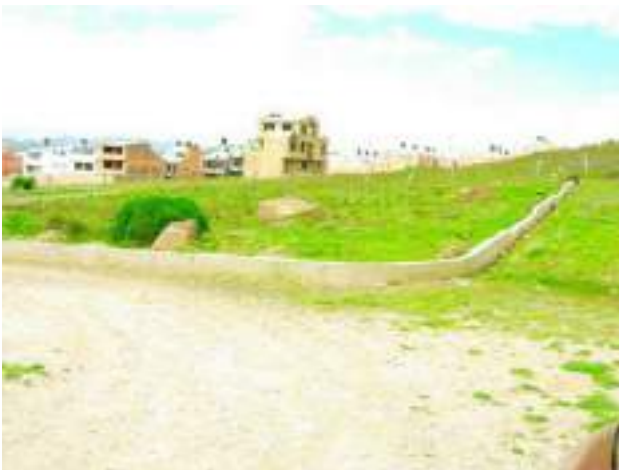
Precariedad de las obras de urbanismo.
