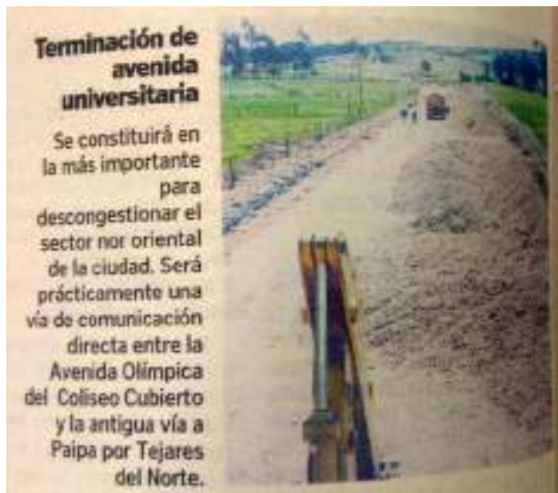
Figura 49. Obras en la Avenida Universitaria para 2003
