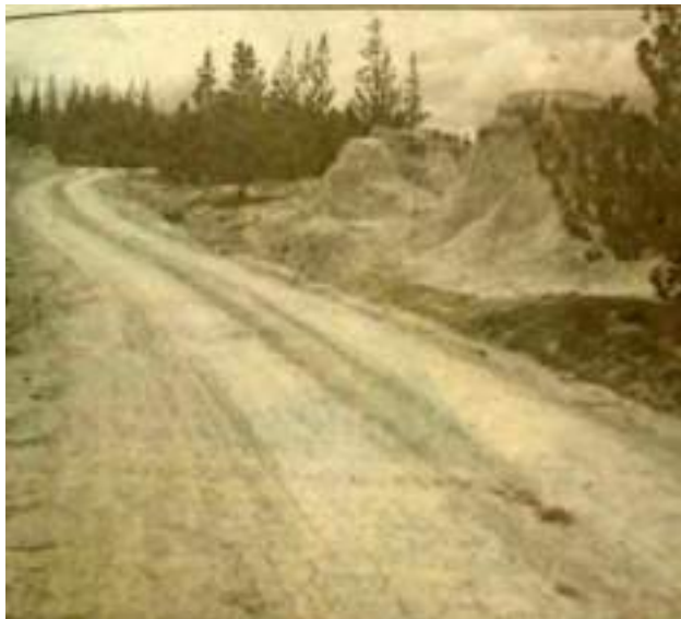
Figura 47. Obras para la variante o perimetral en 1994
