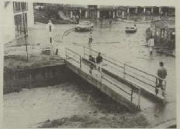
En este sector, donde está ubicado el puente de ingreso al barrio Santa Inés, al pararse, se presenta el problema de represamiento de agua.
