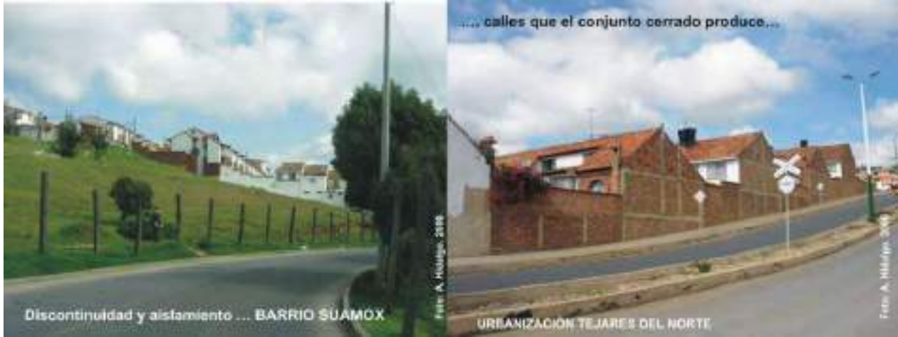
Figura 134. Conjuntos cerrados de vivienda: Suamox y Tejares del Norte
