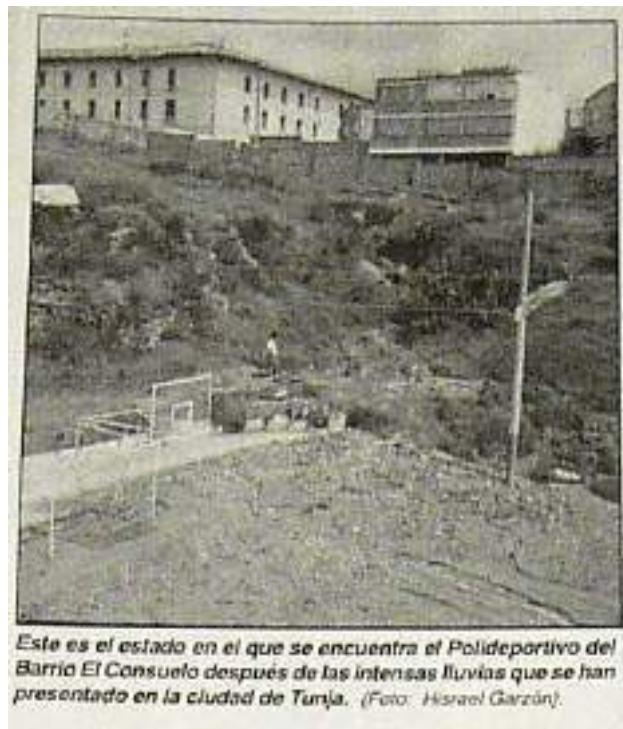
Figura 33. Polideportivo del barrio El Consuelo, dañado por lluvias
