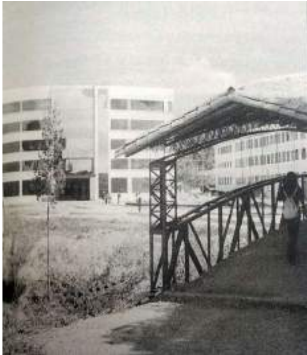
Figura 90. Nuevas edificaciones y mejoramiento de los pasos peatonales en la UPTC
