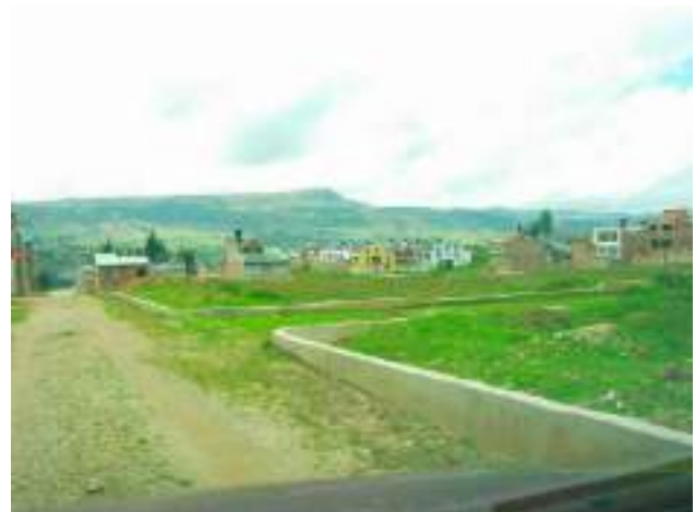
Obras de urbanismo inconclusas.
