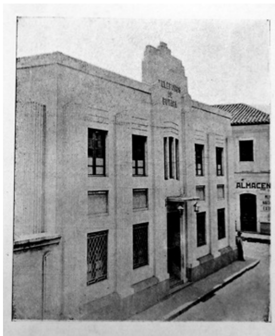
Figura 54. Edificio de teléfonos
