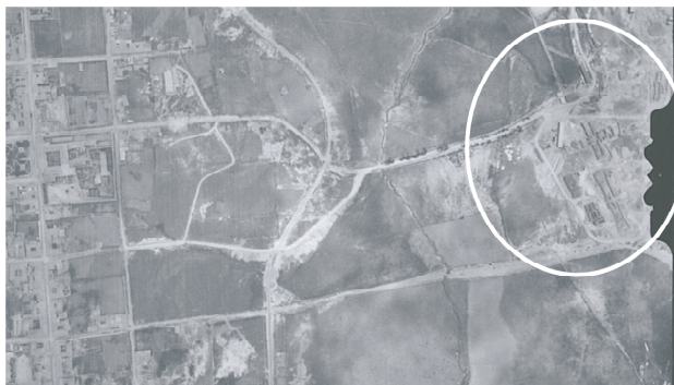
Figura 56. El Batallón Bolívar en construcción en 1939 y su relación con el trazado de Tunja
