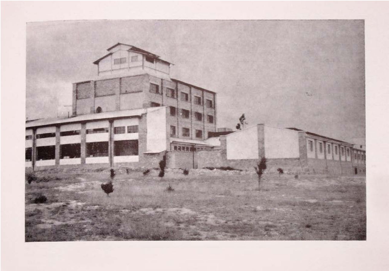
Figura 45. Edificio de la Fábrica de Licores en el barrio Jordán de Tunja
