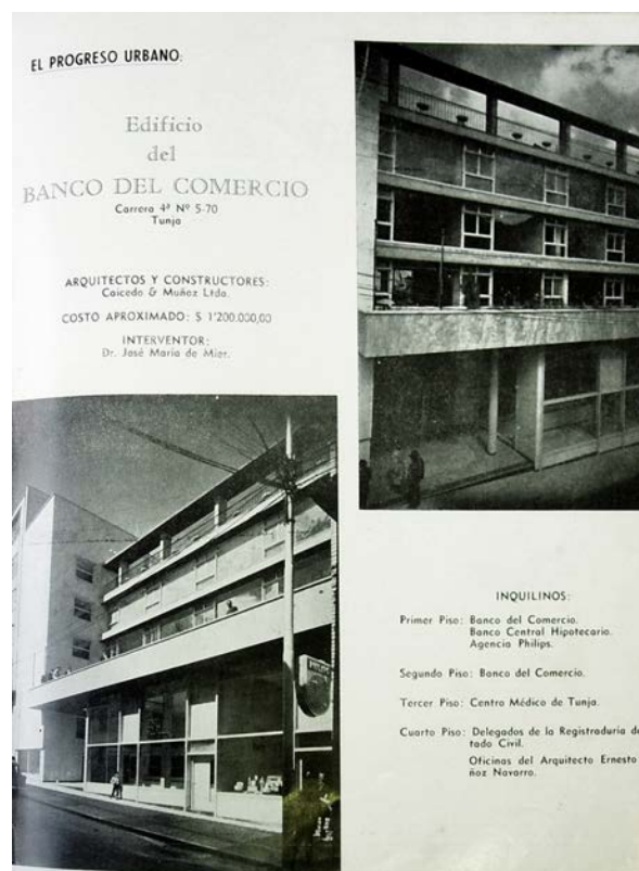
Figura 30. Fotografías del edificio Banco del Comercio representante del progreso urbano
