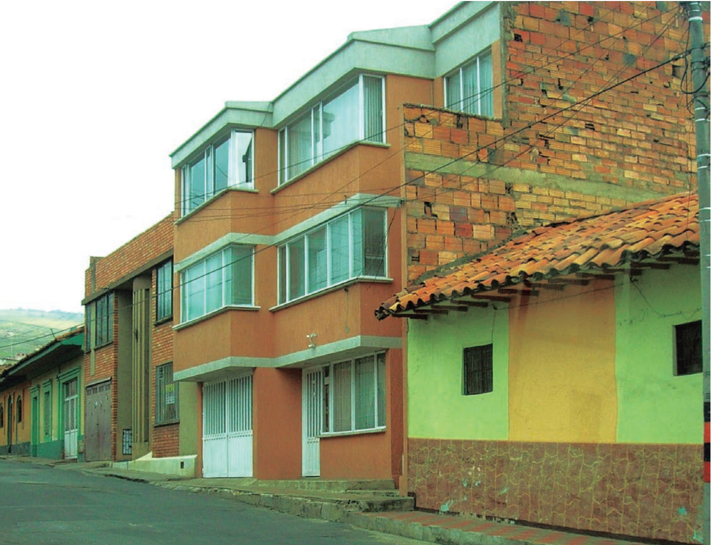
Figura 24. Imagen que refleja el escaso control sobre las normas de paramentación y alturas en el centro histórico de Tunja en 2008
