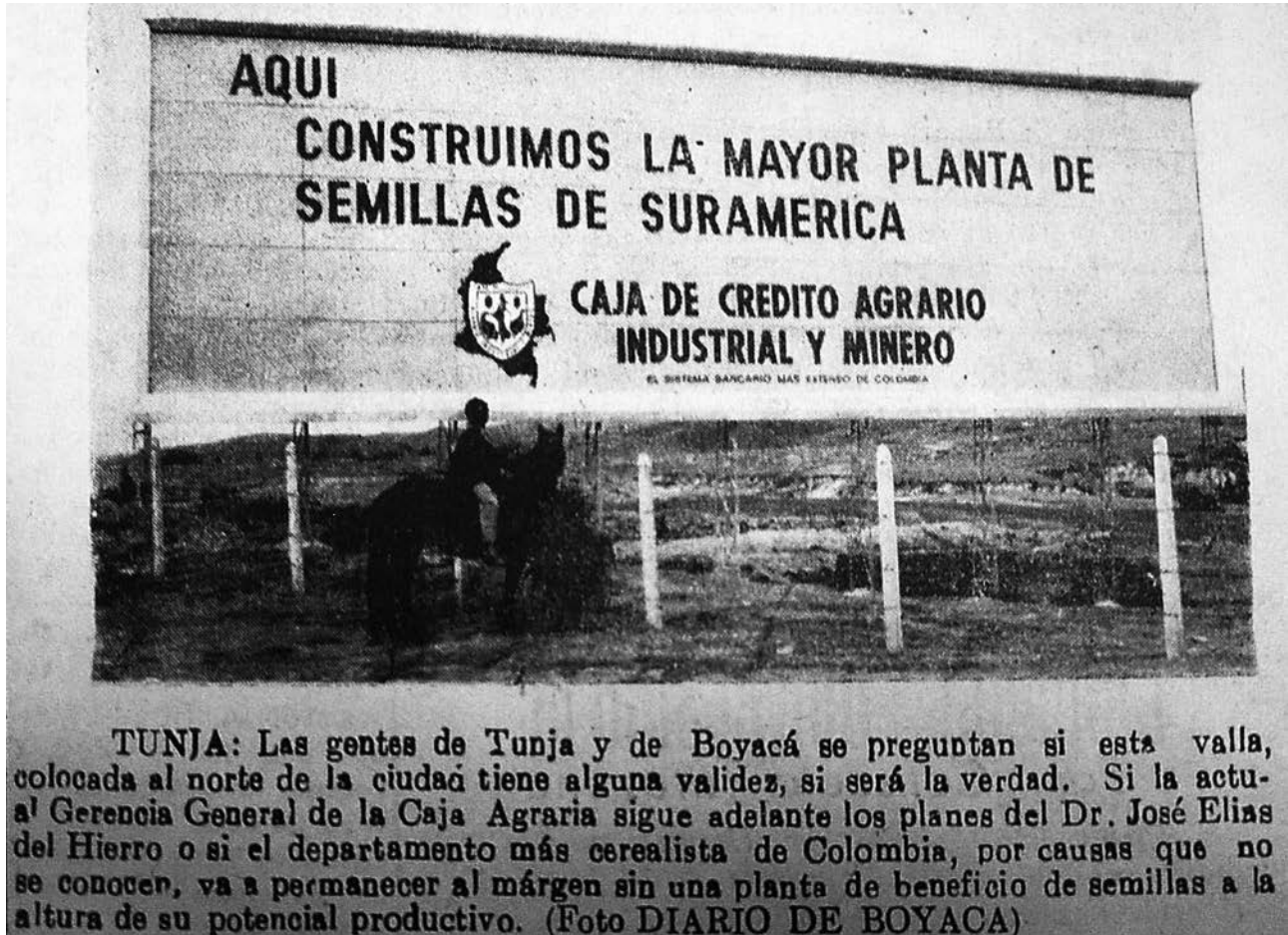
Figura 60. Denuncia relativa a la demora en la construcción de una planta de semillas al norte de Tunja
