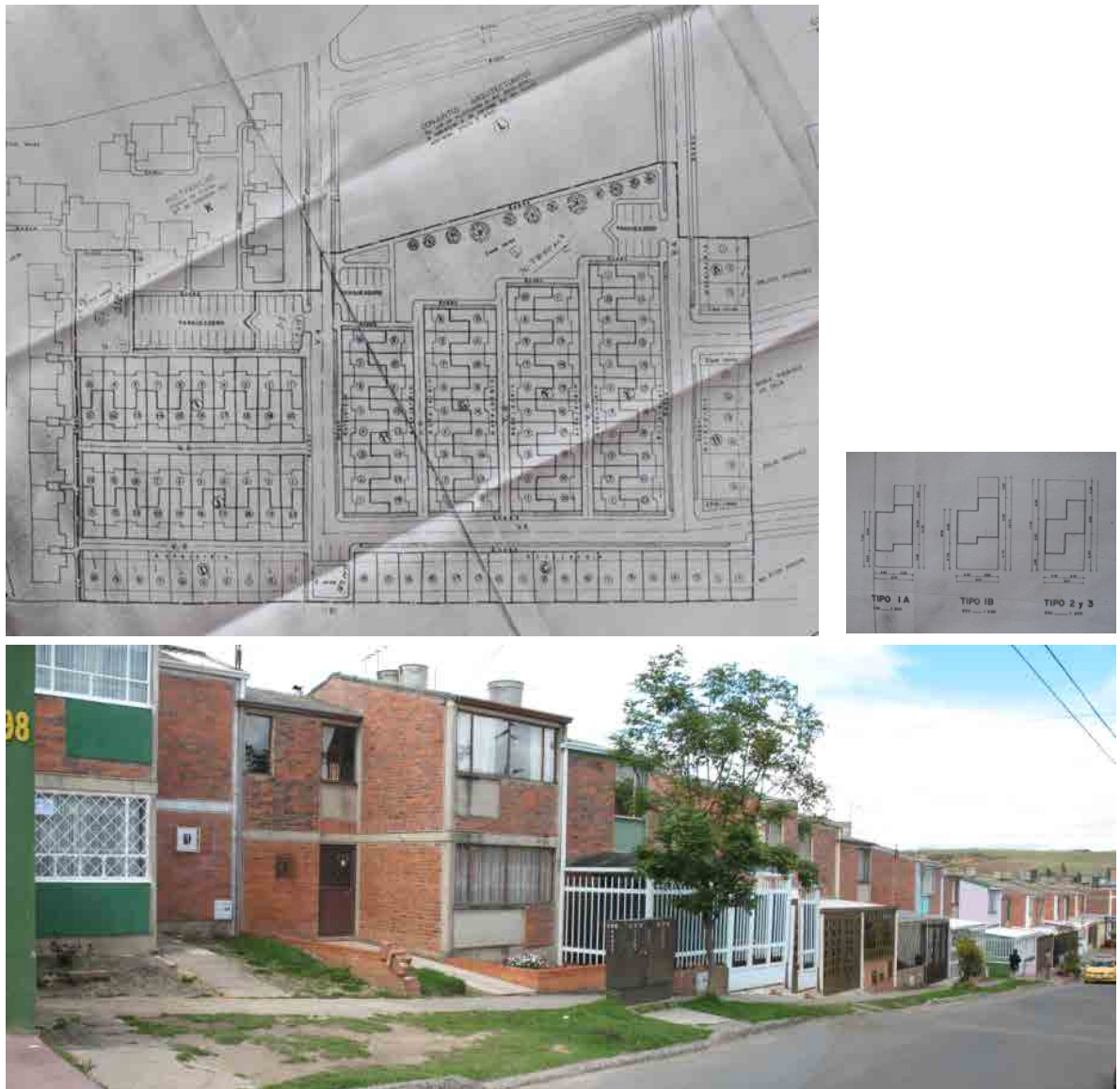
Figura 132. Vivienda unifamiliar en La Florida
