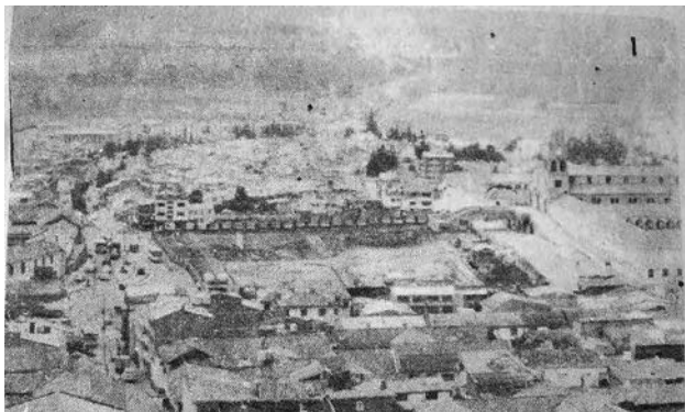
Figura 50. Islote de Las Nieves en espera de intervención para su uso público
