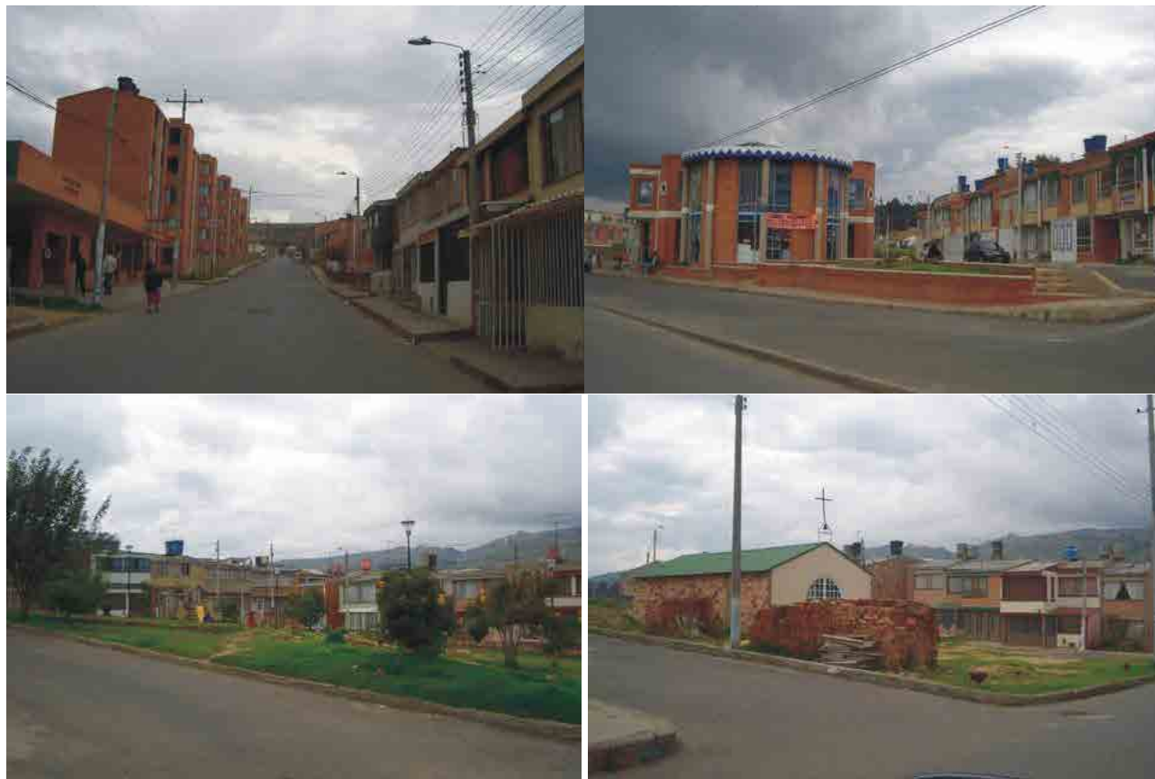
Figura 136. Vías y viviendas en Cooservicios
