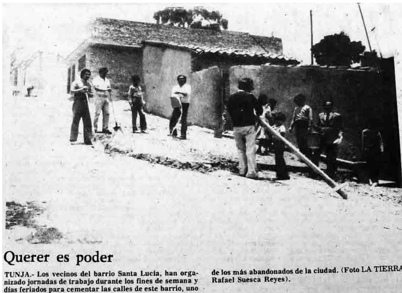
Figura 42. Pavimentación de calles por autogestión en el barrio Santa Lucía
