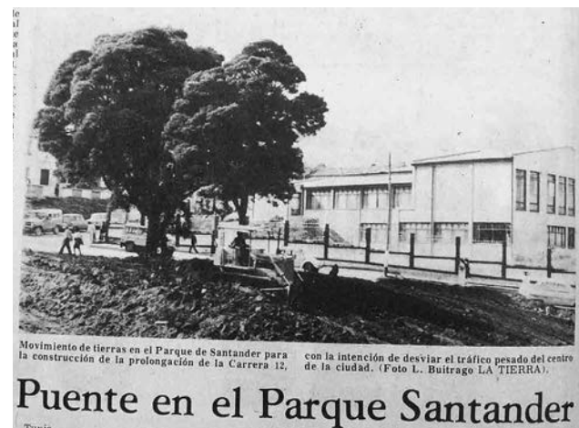
Figura 44. Remoción de tierras para la construcción del puente en el Parque Santander
