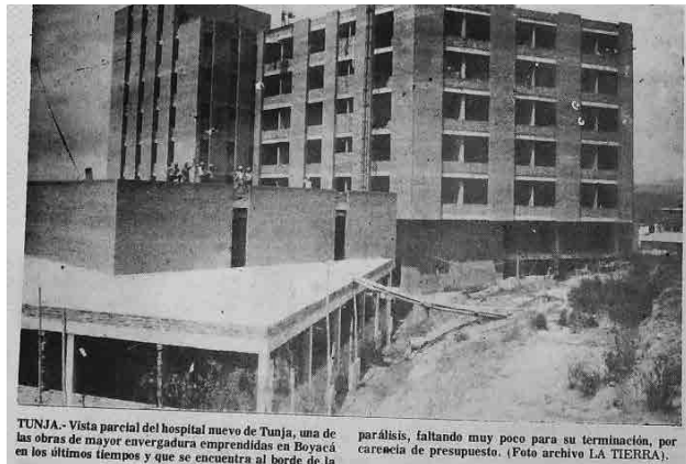
Figura 73. Nuevo hospital de Tunja, aún en construcción en 1986
