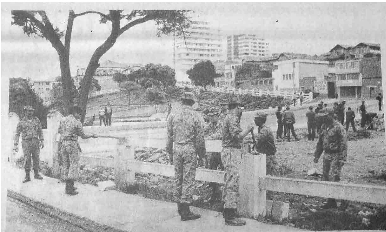
Figura 57. Adecuaciones en el Parque Santander con apoyo del Ejército Nacional
