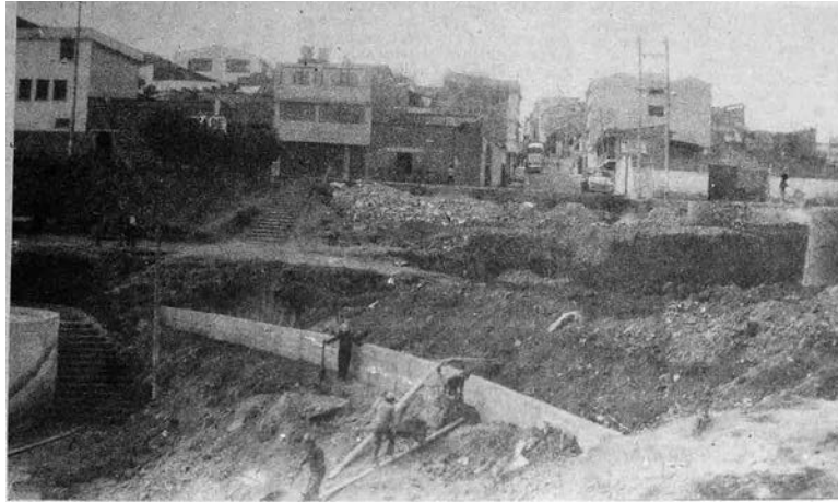
Figura 55. Obras de la concha acústica en el Parque Santander
