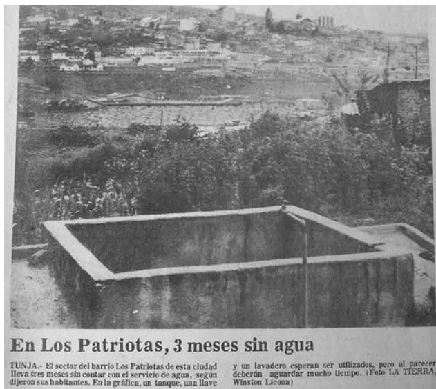
Figura 28. Nota sobre la falta de agua en barrios populares
