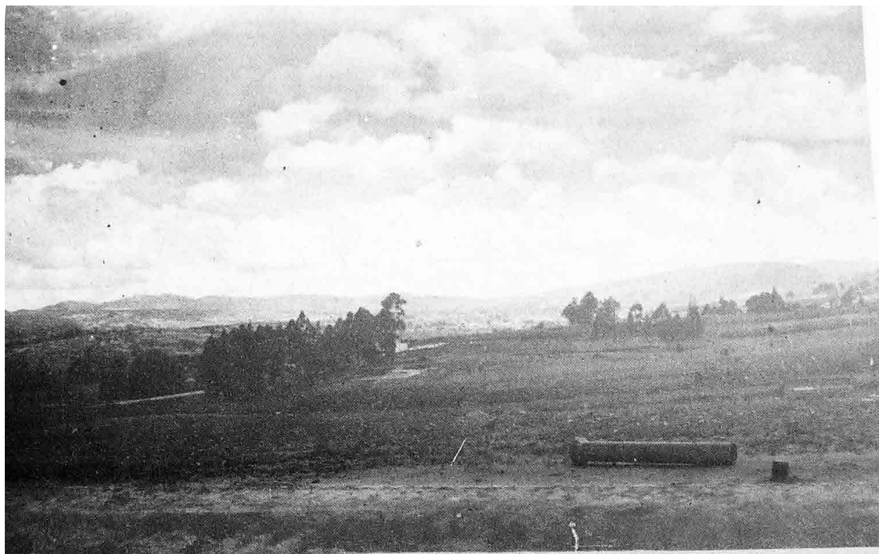
Figura 96. Trabajos en el lote destinado al parque industrial del norte
