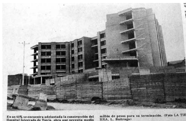
Figura 69. Nuevo hospital de Tunja en construcción en 1984
