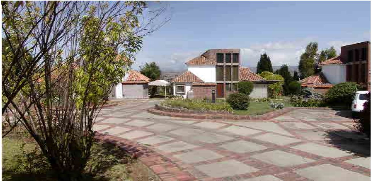
Figura 142. Edificación en las primeras etapas (fase 1) de Las Acacias
