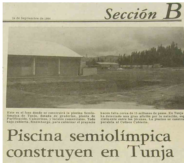
Figura 86. Construcción del foso para la piscina semiolímpica en 1984
