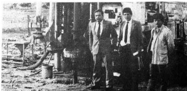
Figura 31. Trabajos en pozos profundos
