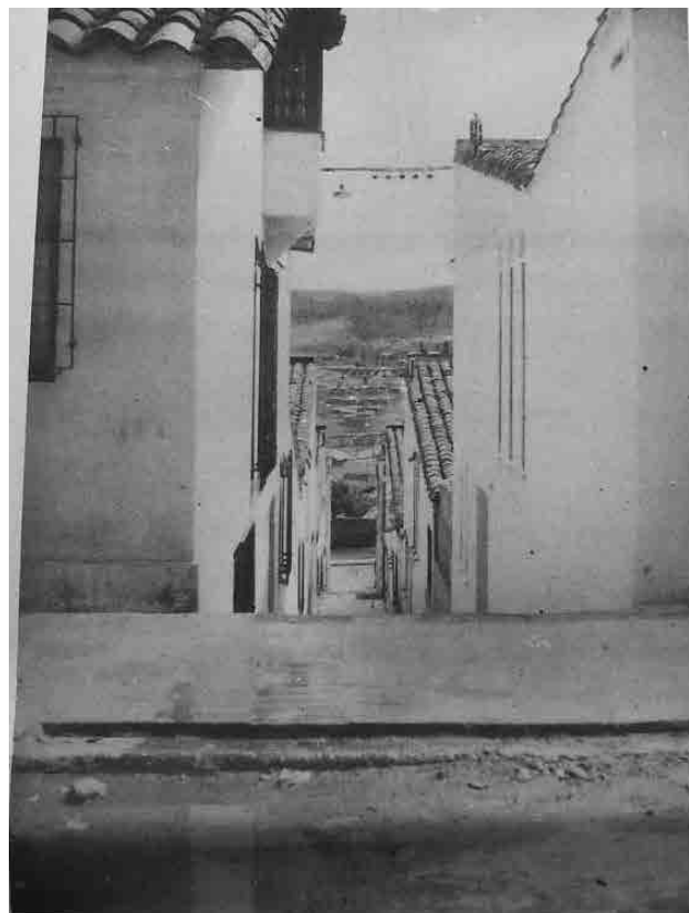
Figura 32. Calles pendientes del barrio El Consuelo con filtraciones de aguas negras
