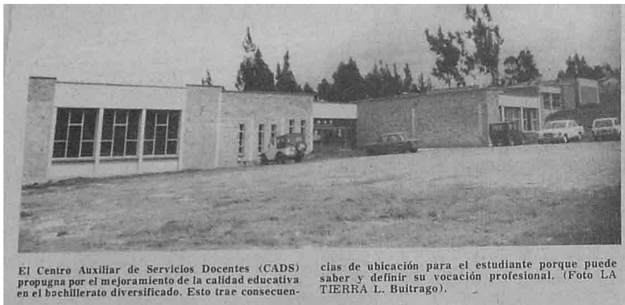
Figura 78. CASD ubicado en el barrio San Antonio
