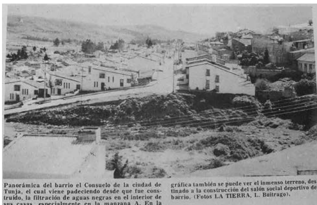
Figura 33. Panorámica del barrio El Consuelo, afectado por filtraciones de aguas negras
