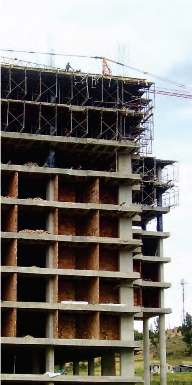
Construcción en el norte de la ciudad
